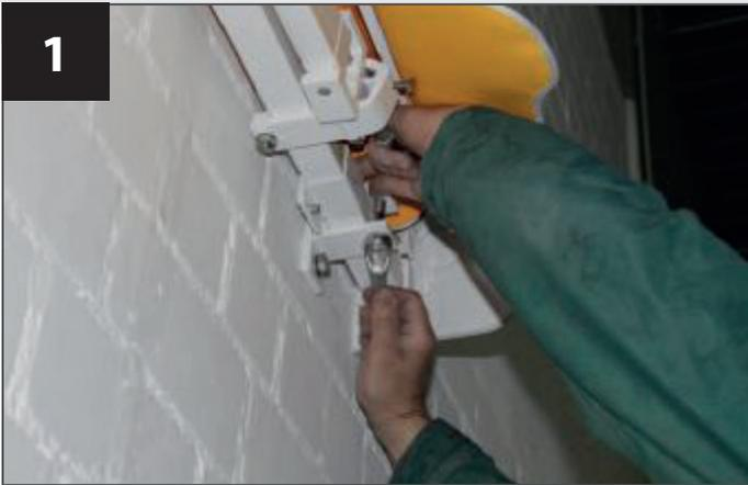
Lösen Sie die Verschraubungen der Konsolen.
