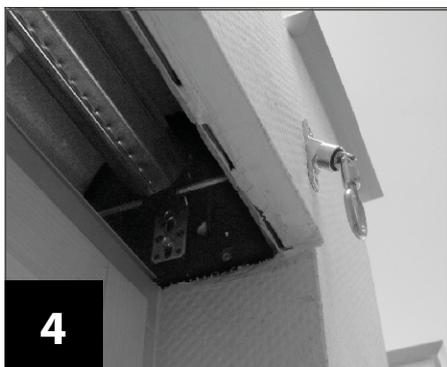
**4** Befestigen Sie nun die Gelenkplatte am Mauerwerk.
