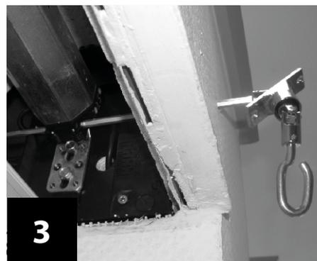
**3** Stecken Sie das Kurbelgelenk durch die Wand in das Nothandgetriebe des Motors.
