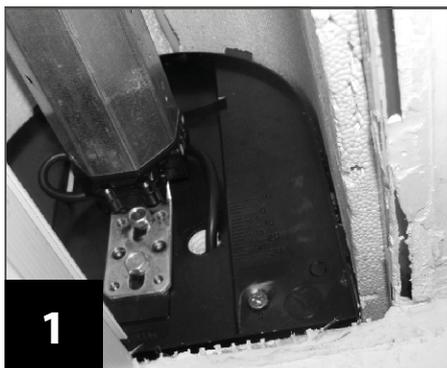
**1** Montieren Sie zunächst den Rohrmotor im Rollladenkasten.
