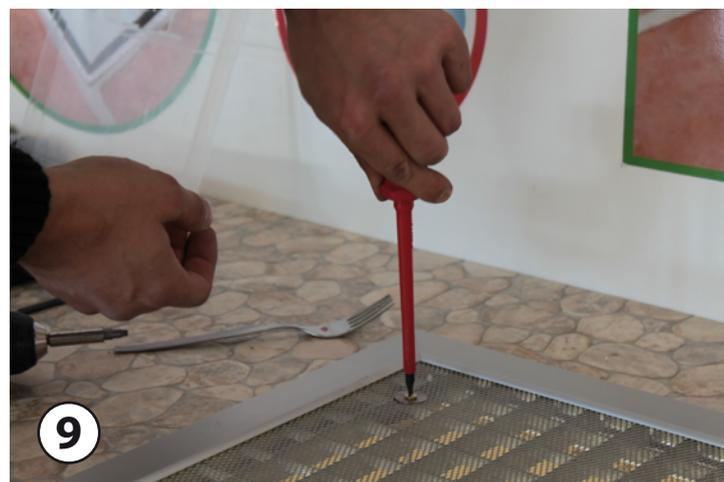
8 Nehmen Sie nun einen Schraubenzieher oder Akkuschauber und schrauben Sie die Klappdübel bei gezogener Beilagscheibe nach unten ein. (**Beachten Sie!** Die Beilagscheibe muss permanent nach oben gezogen werden, da das Maul des Klappdübels andernfalls keinen Halt entwickelt und durchdreht.)
