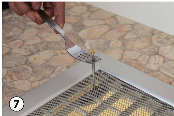
6 Drücken Sie nun die Klappdübel auf allen vier Seiten durch das vorhandene Schachtgitter. Gegebenenfalls muss die Lichtschachtabdeckung hierfür ein Stück angehoben werden.
